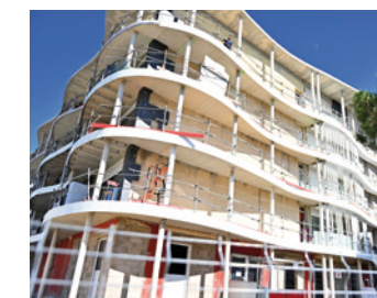
Réhabilitation du Carré Uranus dans le quartier de la Mosson
