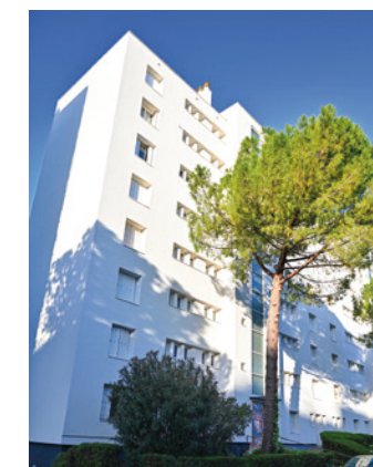
Rénovation de logements dans le quartier Les Aubes
